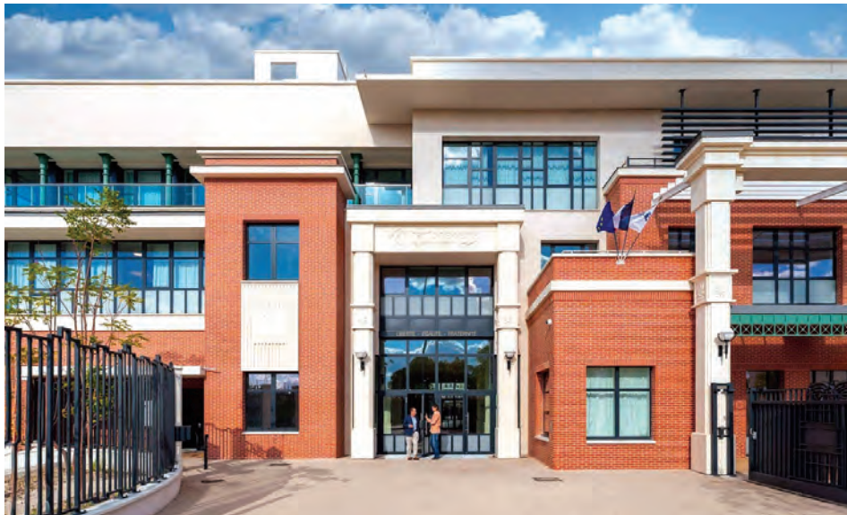
Une entrée monumentale, dans le plus pur style art déco.
